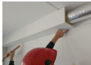
Kasse for montering av downlights
